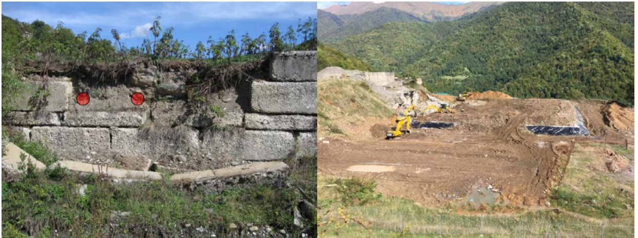
ილ. 14. მარცხნივ: სარკოფაგის რღვევა (წითელ ნიშნულებში დარიშხანის კონცენტრაცია >5000 მგ/კგ); მარჯვნივ: დარიშხანის შემცველი ტოქსიკური ნიადაგის ნარჩენების ლენდფილინგი ურავი 3-ზე.
